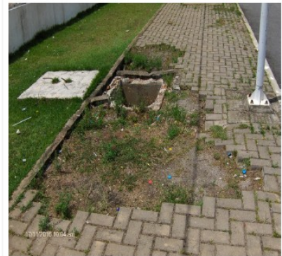
Fotos 05 e 06 – Passeio na Praça 9 de Julho: Afundamento/deformação e arrancamento do piso em bloco intertravado (situação em novembro/2016)
