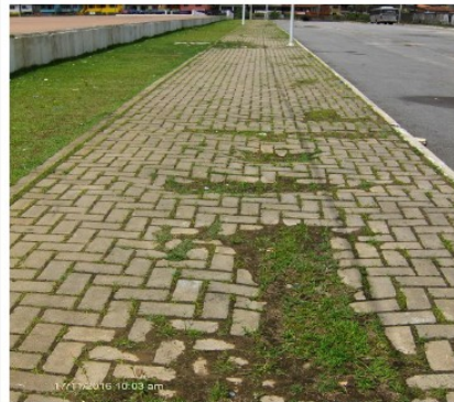
Fotos 05 e 06 – Passeio na Praça 9 de Julho: Afundamento/deformação e arrancamento do piso em bloco intertravado (situação em novembro/2016)
