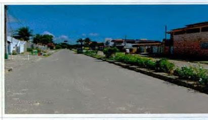
Foto 03 – Avenida 05 (vistoria in loco em 22/11/2016)
